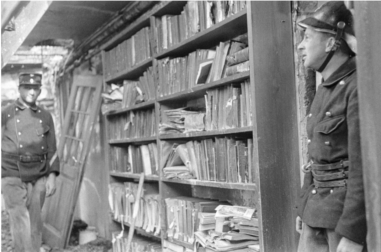
Die Bibliothek von Max Huber im Schloss Wyden erlitt arge Schäden, nicht zuletzt auch durch Löschwasser. Staatsarchiv Aargau / Ringier Bildarchiv John Gugelmann © StAAG/RBA1-10-879_1.
